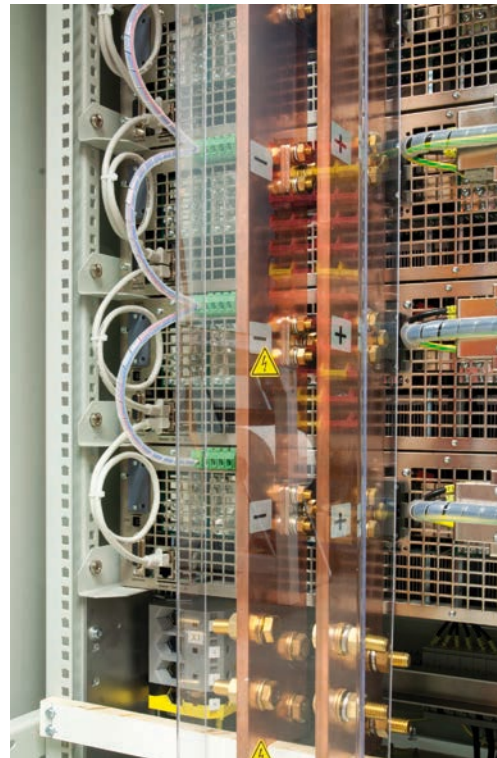
DC-Anschluß / DC bus terminal
